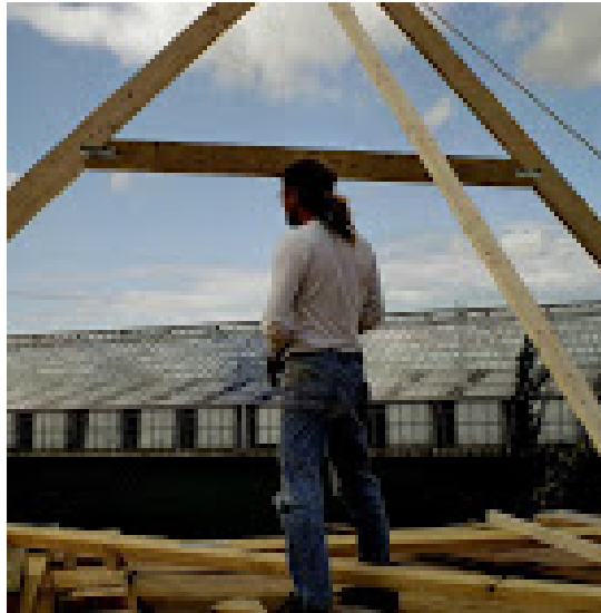
Første hus ved spærrejsning, 2002.
