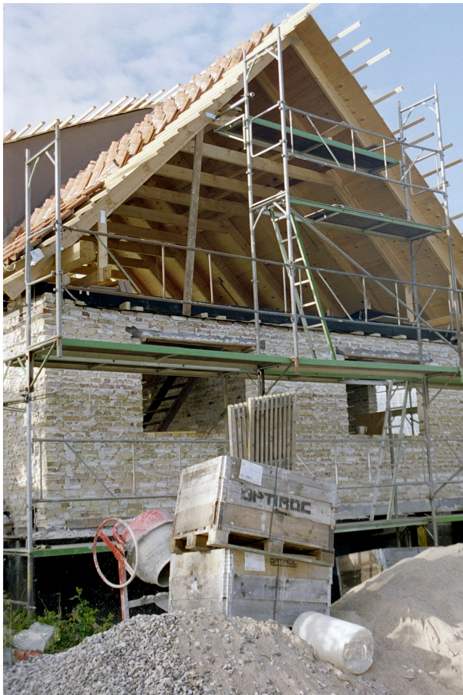
Det tog noget over en måned at lave tagkonstruktion og tag.
