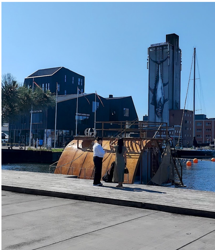
Ark, husbåd under opførelse på åbent vand.
